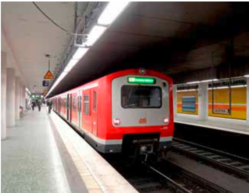
Die unterirdische Bahnsteighalle für die S-Bahn
