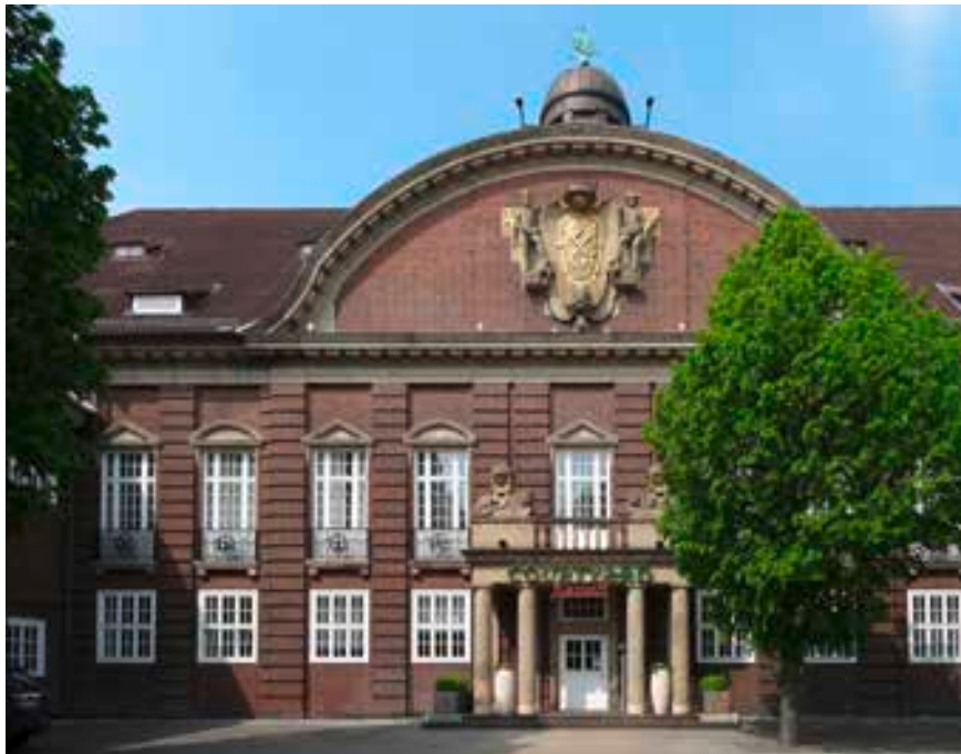
Der ehemalige Lloyd-Bahnhof steht seit 2001 unter Denkmalschutz.
