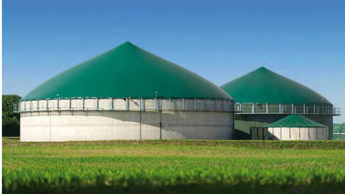
In Biogasanlagen werden biologische Materialien durch anaerobe Mikroorganismen vergärt. Archaeen sind im letzten Schritt für die Produktion des Methans verantwortlich, das brennbar ist und der Hauptkomponente von Erdgas entspricht.
